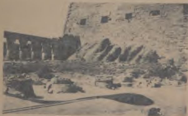
2. ÉCHAFAUDAGES ANTIQUES DE CONSTRUCTION
